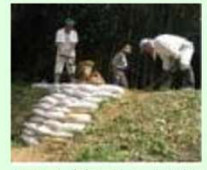
漏水箇所の補修
