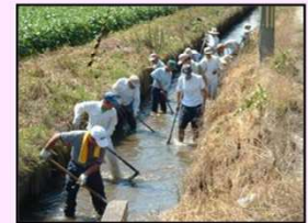
水路の泥上げ
