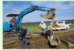
コンクリート水路の更新
