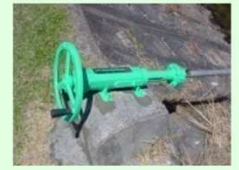
ゲート、バルブの更新
