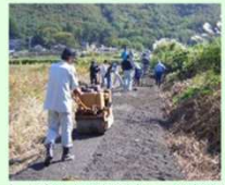
未舗装農道の舗装
