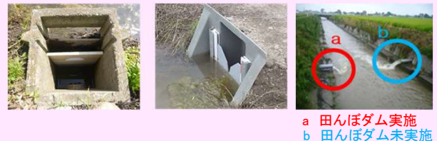
流出を抑制する落水量調整装置の例
