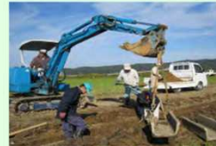
コンクリート水路の更新
