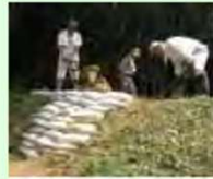
漏水箇所の補修
