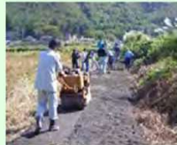
未舗装農道の舗装
