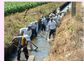
水路の泥上げ
