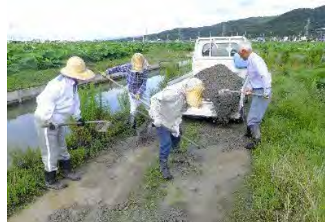
農道の路面の補修(バラス入れ)
