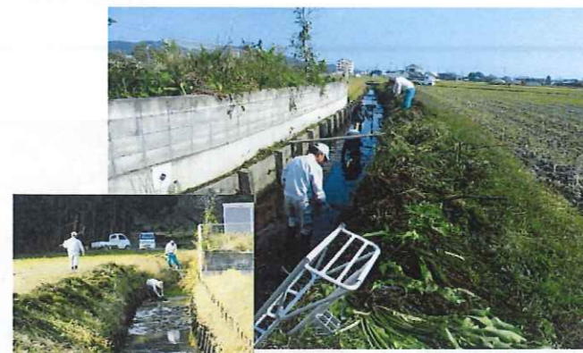
開水路泥上げ草刈り作業 (西浦土地改良組合)
