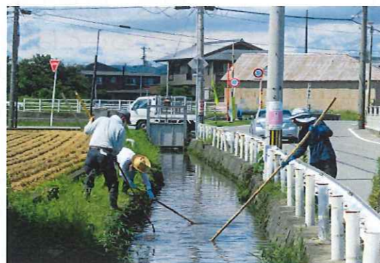
下湯開水路藻刈り作業 (田野芝生土地改良区)
