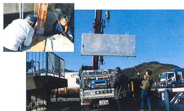
源氏橋樋門取替作業 (田野芝生土地改良区)
