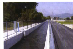
完成後の管水路
