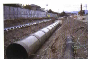
工事実施状況
