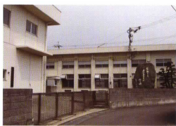
中島揚水機場と中島加圧揚水機場(手前)
