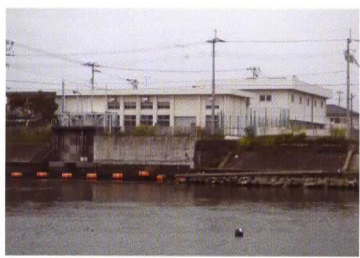
旧吉野川からの取水口と中島揚水機場
