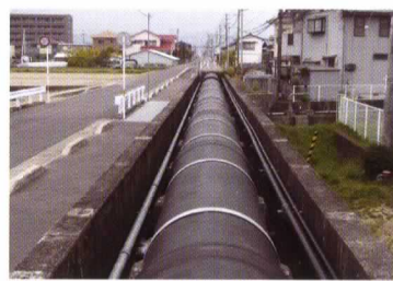
旧水路に管水路を埋設
