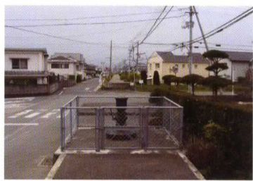
旧水路に管水路を埋設
