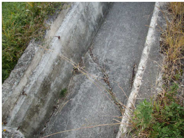
コンクリート水路
