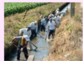
水路の泥上げ
