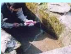
水路のひび割れ補修
