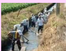
水路の泥上げ
