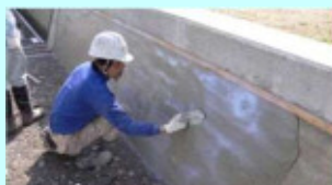
老朽化した水路壁のコーティング
