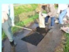
農道の部分補修
