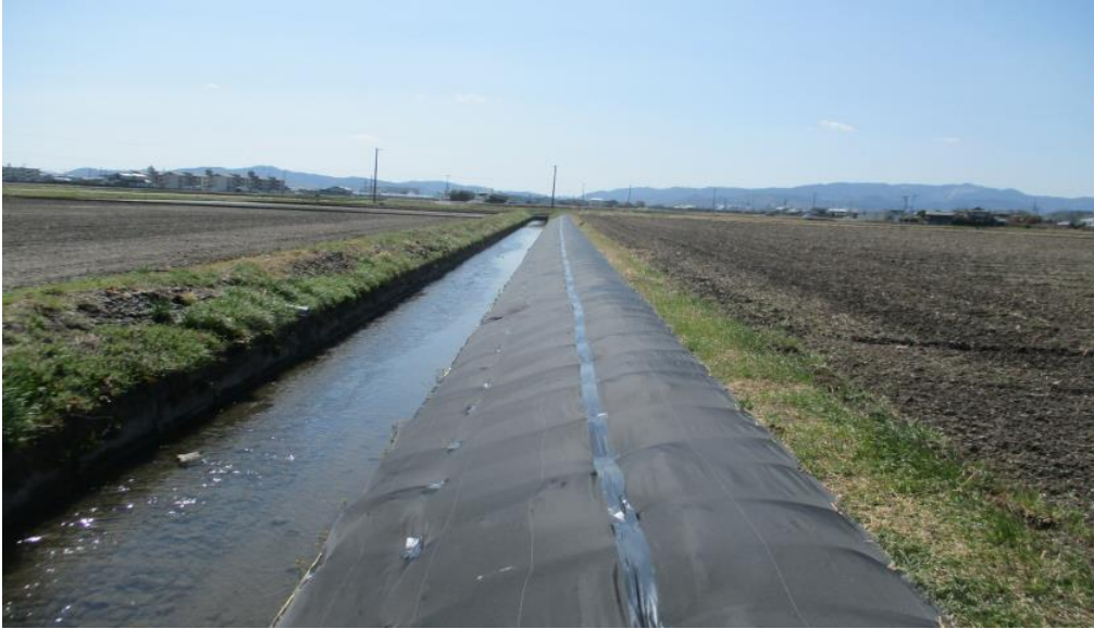
水路法面に防草シートを施工（高齢化に対処）
