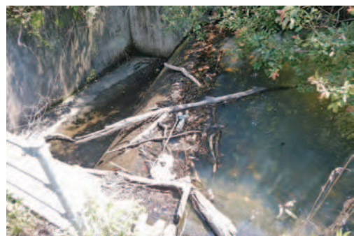
洪水吐に異物が流入している状況
