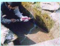
水路のひび割れ補修
