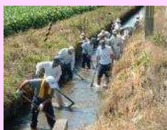
水路の泥上げ
