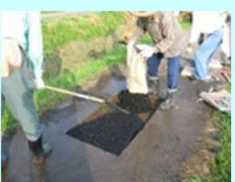
農道の部分補修
