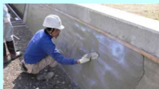
老朽化した水路壁のコーティング
