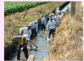
水路の泥上げ
