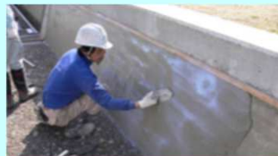
老朽化した水路壁のコーティング
