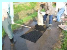
農道の部分補修
