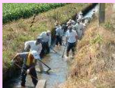
水路の泥上げ
