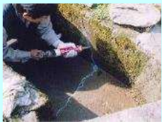
水路のひび割れ補修
