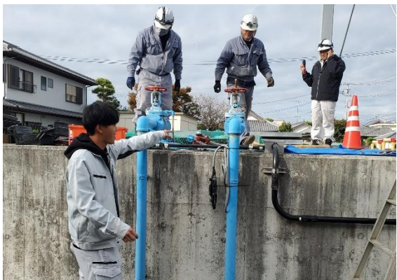
榎瀬揚水機場 冷却水ポンプ更新
