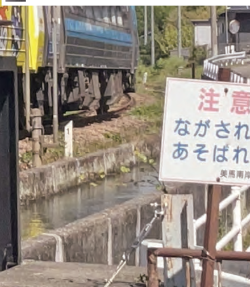
幹線用水路の遠隔監視システム（つるぎ町貞光）
